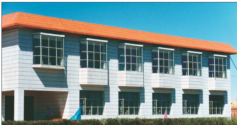
Здание Силингольской экологической станции.
